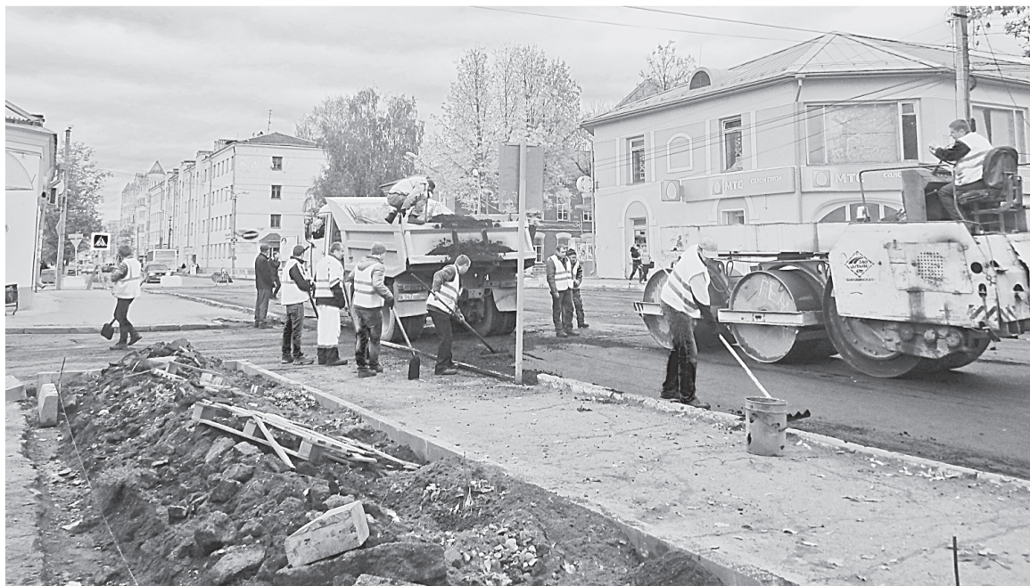
Ремонт улицы Подбельского
